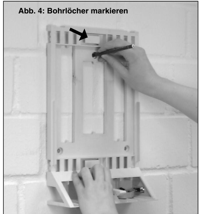
Abb. 4: Bohrlöcher markieren
